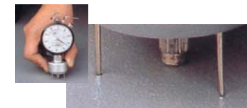
測定の度に防水層に穴が…
