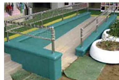
安全対策施設
