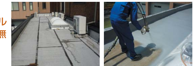
吹付け2回目で平滑 被覆性能が高く下地処理を せずに防水施工が可能です。
