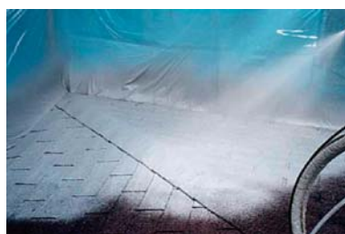
シングル屋根改修
