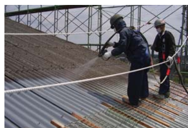
スレート屋根改修
