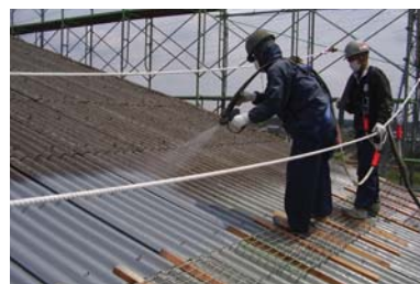
スレート屋根改修
