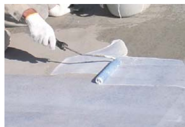
プライマー塗布
