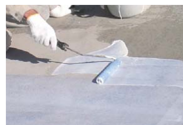
プライマー塗布
